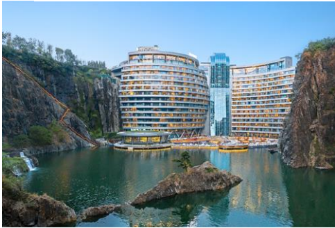
上海世茂洲際 景觀露台房 (房間面積約 420 呎)
