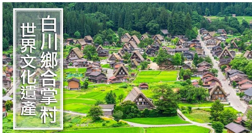
300 年前居民為了適應山谷環境，將木造住家屋頂設計成 60 度斜角的正三角形。除了可以抵擋寒風外，這角度也使得屋頂可以承載厚重積雪，同時讓積雪自然崩落。除此之外，合掌屋只用繩子與木材搭建，完全不使用釘子，屋頂以厚厚的茅草覆蓋，外形有如兩手合握，看似簡單的構造卻經得起風吹雨打、大雪、地震的考驗，體現先人的智慧！一間間共 114 棟的合掌屋座落在群山環繞中，一旁有源於飛驒山脈的雪水形成的河流，漫步其中宛如走入日版童話世界裡的薑餅屋故事中。村內還按古代農村的模樣，建有寺廟、水車小屋、燒炭小屋、馬廄等建築。
